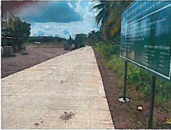
๗. ก่อสร้างถนนคอนกรีตเสริมเหล็ก ขอยอนามัย หมู่ที่ ๑ บ้านหินกอง
