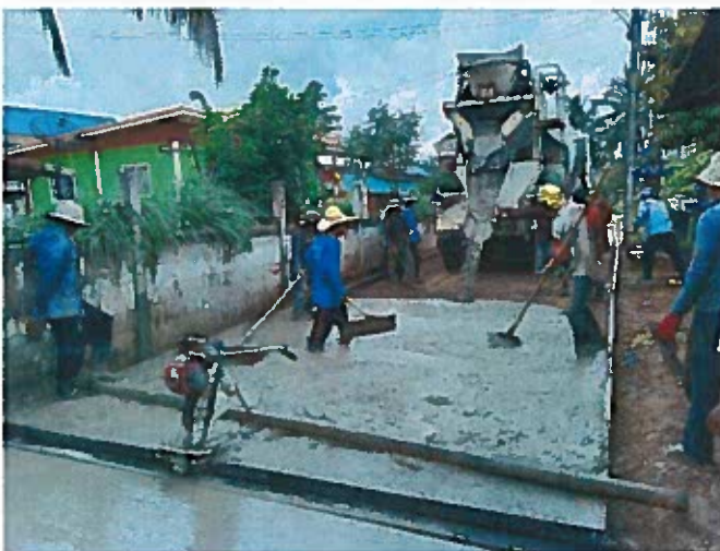
๙. ก่อสร้างถนนคอนกรีตเสริมเหล็ก ซอยแสงดาว หมู่ที่ ๖ บ้านโนนสมบูรณ์
