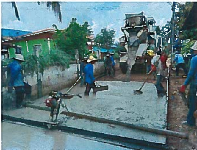
๙. ก่อสร้างถนนคอนกรีตเสริมเหล็ก ขอยแสงดาว หมู่ที่ ๖ บ้านโนนสมบูรณ์
