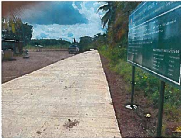
๗. ก่อสร้างถนนคอนกรีตเสริมเหล็ก ซอยอนามัย หมู่ที่ ๑ บ้านหินกอง
