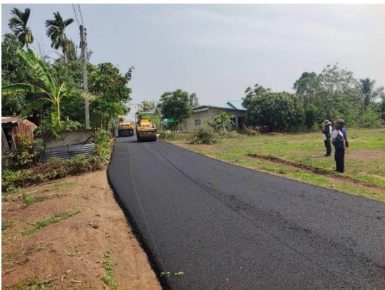
๖.โครงการปรับปรุงถนนคอนกรีตเสริมเหล็กโดยเสริมผิวแอสฟัลติกคอนกรีต ซอยข้างวัดคลองยาง หมู่ที่ ๕ บ้านคลองยาง
