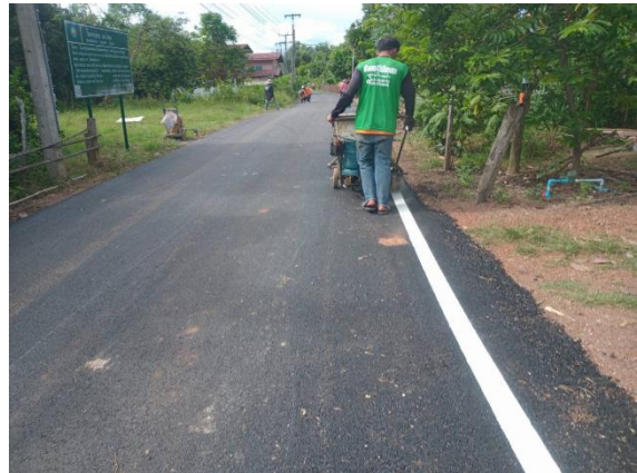
๑๙. โครงการปรับปรุงถนนคอนกรีตเสริมเหล็กโดยเสริมผิวแอสฟัลติกคอนกรีต ซอยบ้านโนนสมบูรณ์ หมู่ที่ ๖ บ้านโนนสมบูรณ์
