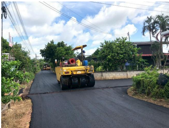
๑๙. โครงการปรับปรุงถนนคอนกรีตเสริมเหล็กโดยเสริมผิวแอสฟัลติกคอนกรีต ซอยบ้านโนนสมบูรณ์ หมู่ที่ ๖ บ้านโนนสมบูรณ์
