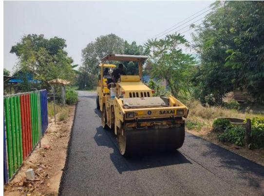
๖.โครงการปรับปรุงถนนคอนกรีตเสริมเหล็กโดยเสริมผิวแอสฟัลติกคอนกรีต ซอยข้างวัดคลองยาง หมู่ที่ ๕ บ้านคลองยาง
