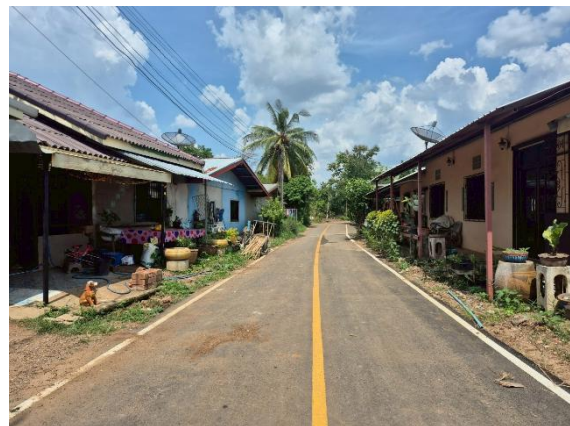
๑๗. โครงการปรับปรุงถนนคอนกรีตเสริมเหล็กโดยเสริมผิวแอสฟัลติกคอนกรีต ซอยแม่กอง หมู่ที่ ๕ บ้านคลองยาง
